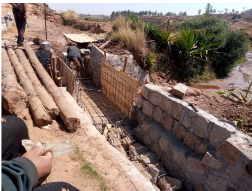
Réparation de la tête morte par les usagers, 2025
