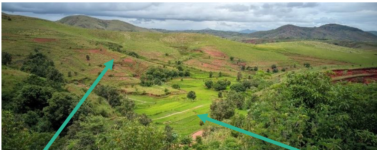
Photo 14 : Bassin versant en cours de restauration dans une zone du Vakinankaratra
