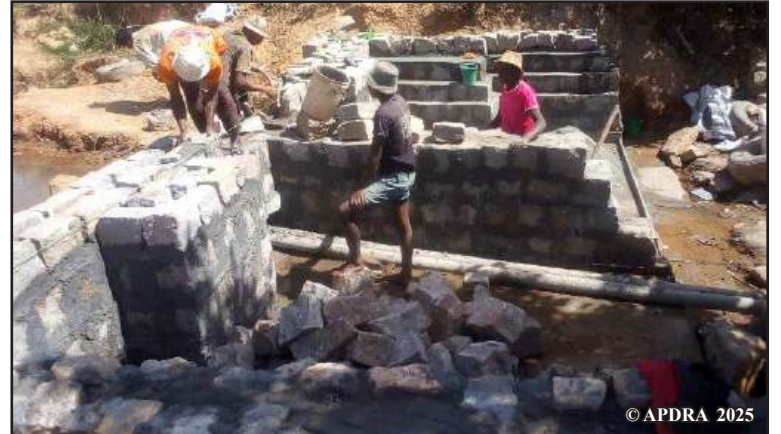
Travaux de réhabilitation du barrage
