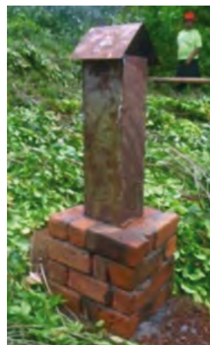
(B) Cheminée munie d'un volet réglable
