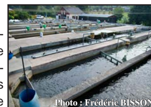
Installations exigées en pisciculture intensive
