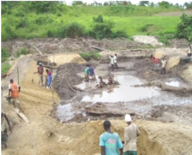
Étang de dérivation en construction—Macenta—Guinée
