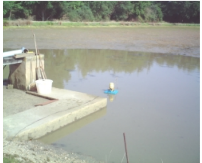
Étang en cours de vidange—Orléans—France
