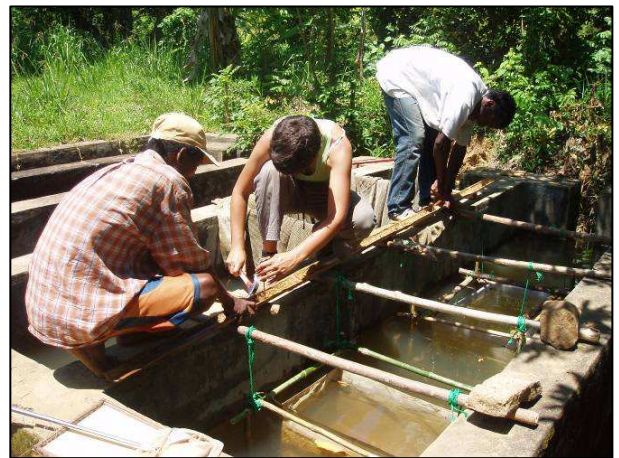
Photo 14: Confection d'une rampe pour l'oxygénation des bassins.
