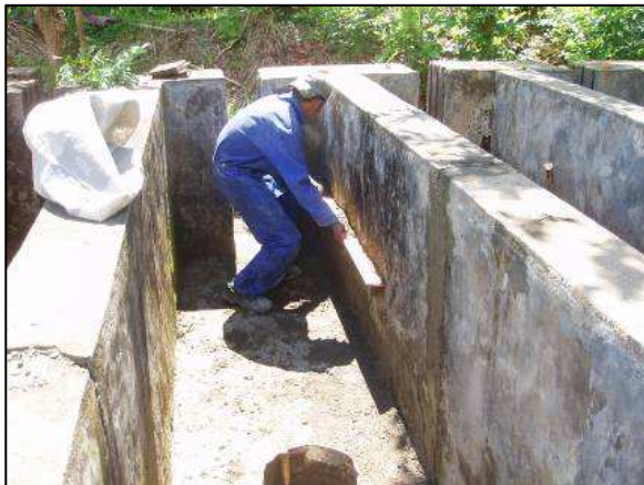
Photo 9: Réhabilitation de trois bassins en ciment utilisés pour la ponte. Le canal d'alimentation a également été réhabilité.
